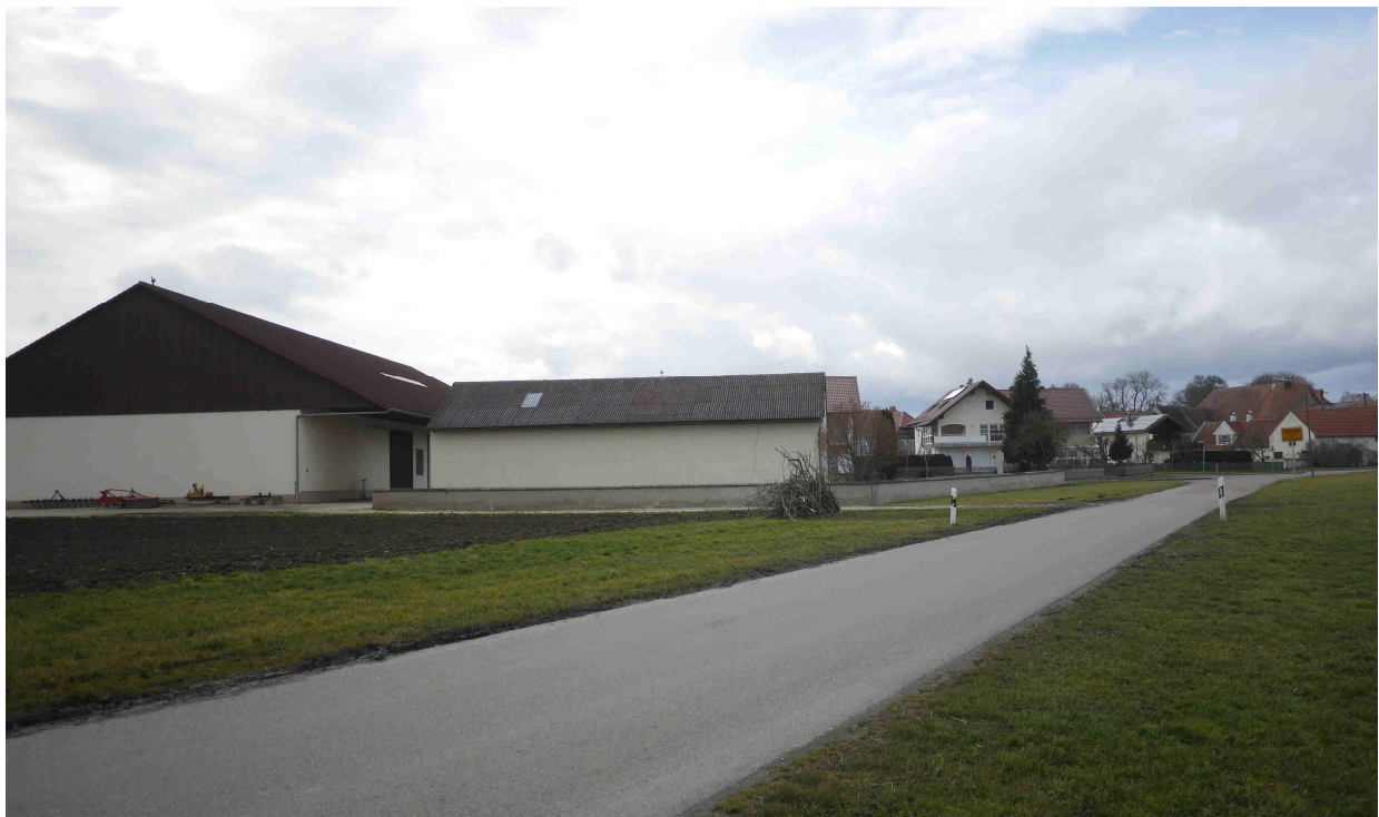
Abb. 6: Blick von Südosten auf den bisherigen Ortseingang (westlich Ortsstraße)
